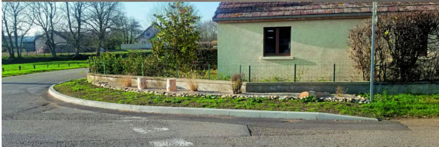
**X Réfection des affaissements sur voie communale n°2 au lieudit « la Croze » et rue du Château.** Les travaux ont permis grâce à la réalisation d'engravure et la pose d'enrobé 0/10 en rechargement, de reprendre des affaissements qui devenaient dangereux pour les véhicules. Coût des travaux : 2 958 € HT. Financement à 30 % du Département.
